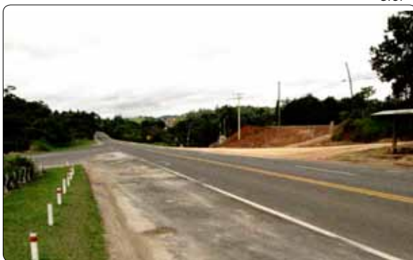
De acordo com o DER, uma das rotatórias será construída no acesso à barragem, em Serra Negra. No local, os técnicos do Departamento de Estradas de Rodagem já realizaram o estudo, conforme exigência da Secretaria dos Transportes.
