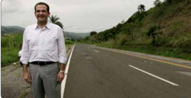
Deputado estadual Edmir Chedid vistoria SP-360 (Rod. Eng. Constâncio Cintra) entre Amparo e Águas de Lindóia.
